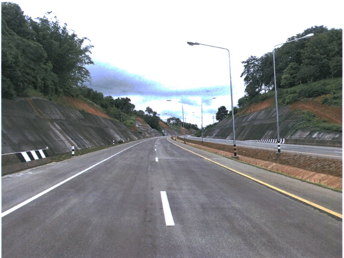
รูปถนนบริเวณ กม.๑๐+๖๐๐.๐๐๐ เมื่อก่อสร้างแล้วเสร็จ
