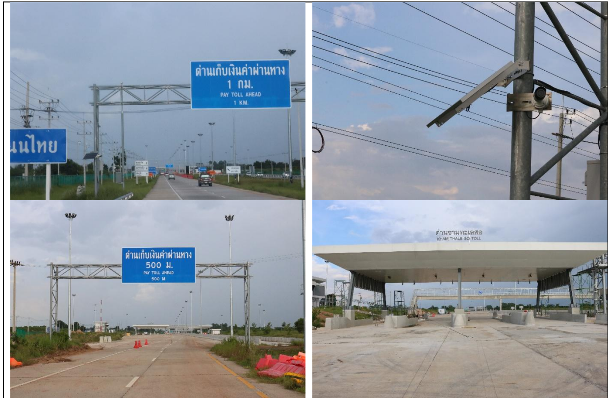
รูปที่ ๖ - 6 สภาพถนนและบริเวณด่านชาวมทะเลสอที่ยังอยู่ในระหว่างก่อสร้าง
