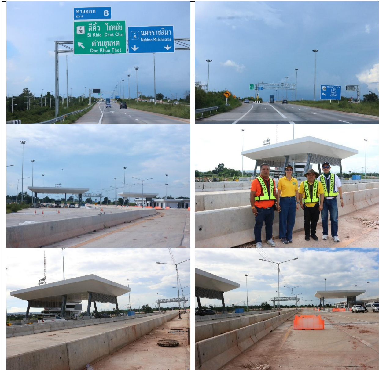
รูปที่ ก - 5 สภาพถนนและบริเวณด้านสี่คี่ที่ยังอยู่ในระหว่างก่อสร้าง
