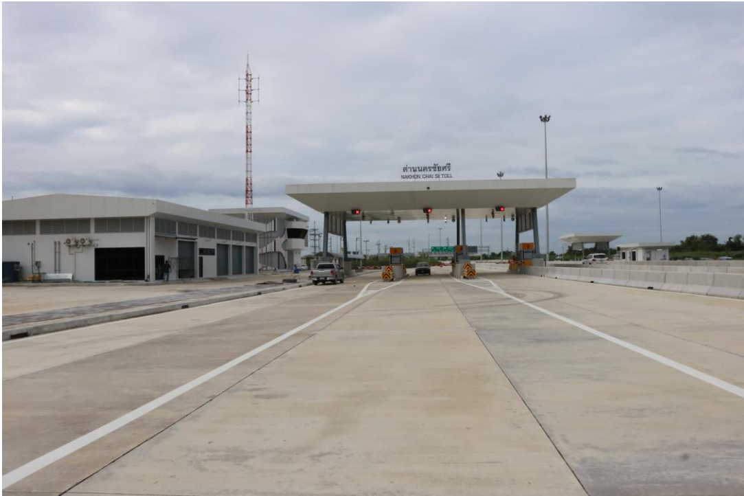
รูปที่ ก - 3 ด่านเก็บค่าผ่านทาง ด่านนครชัยศรี ทางหลวงพิเศษระหว่างเมือง M81 บริเวณ กม.24+700
