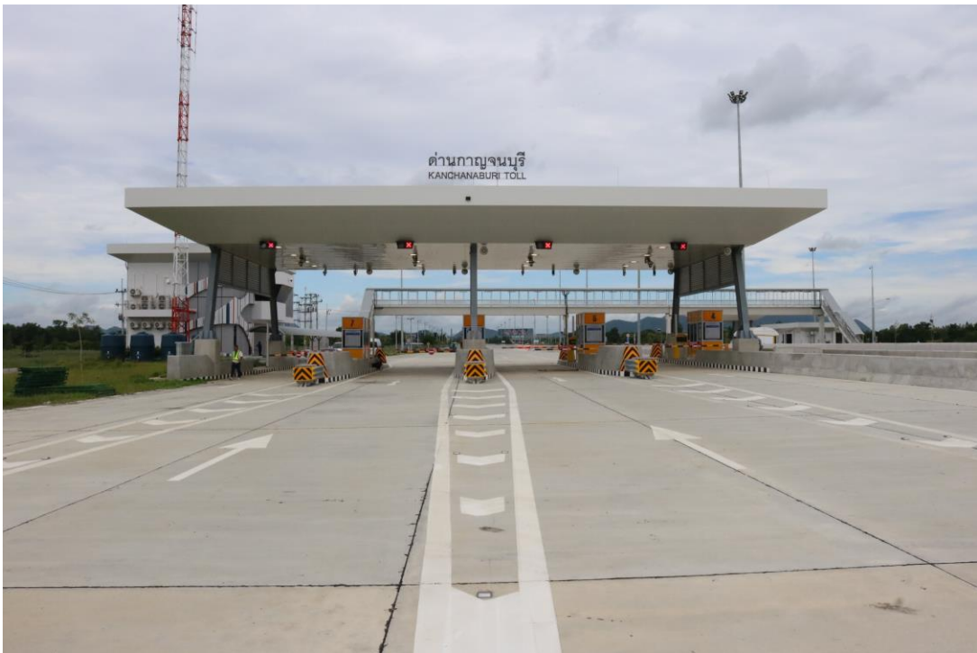
รูปที่ ก - 8 ด้านเก็บค่าผ่านทาง ด่านกาญจนบุรี ทางหลวงพิเศษระหว่างเมือง M81 บริเวณ กม.95+000
