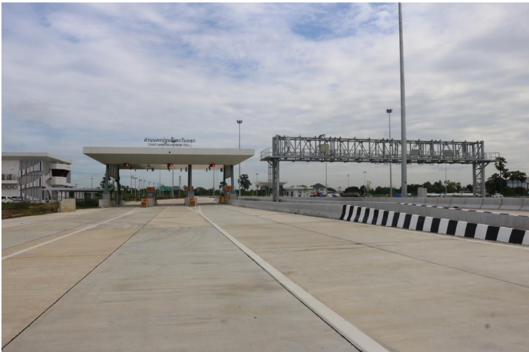
รูปที่ ก - 4 ด่านเก็บค่าผ่านทาง ด่านนครปฐมฝั่งตะวันออก ทางหลวงพิเศษระหว่างเมือง M81 บริเวณ กม.37+600
