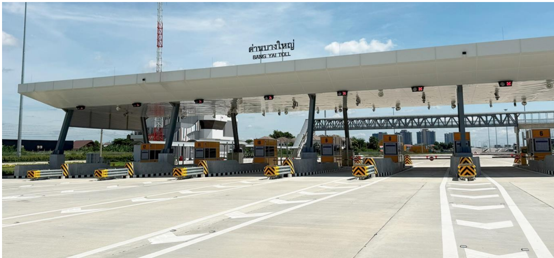
รูปที่ ก - 1 ด้านเก็บค่าผ่านทาง ด้านบางใหญ่ ทางหลวงพิเศษระหว่างเมือง M81 บริเวณ กม.3+500 (ขาเข้า)
