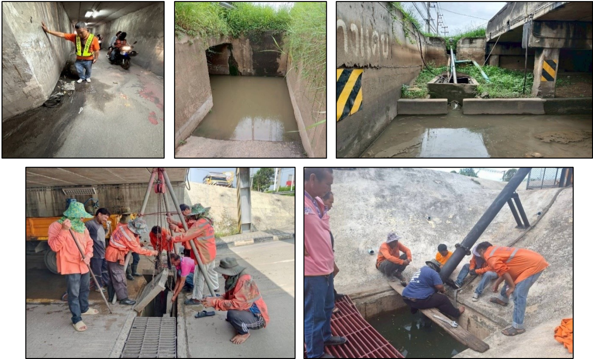
รูปที่ 4-3 การซ่อมแซมบำรุงรักษาทางลอด
