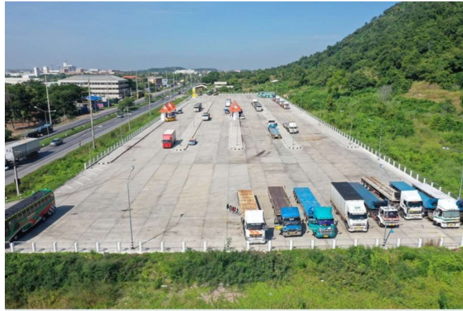
รูปที่ 2-2 จุดพักรถขนาดกลาง จุดพักรถหนองแค ทล.33 กม.92+700
