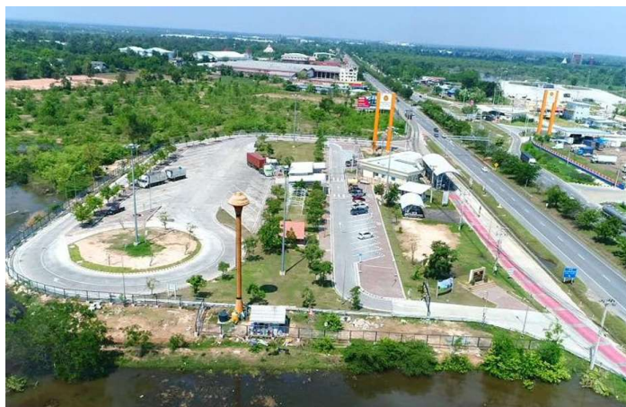
รูปที่ 2-1 จุดพักรถขนาดใหญ่ อ.โนนสูง จ.นครราชสีมา ทล. 2 ตอน นครราชสีมา - โนนสูง กม.169+800
