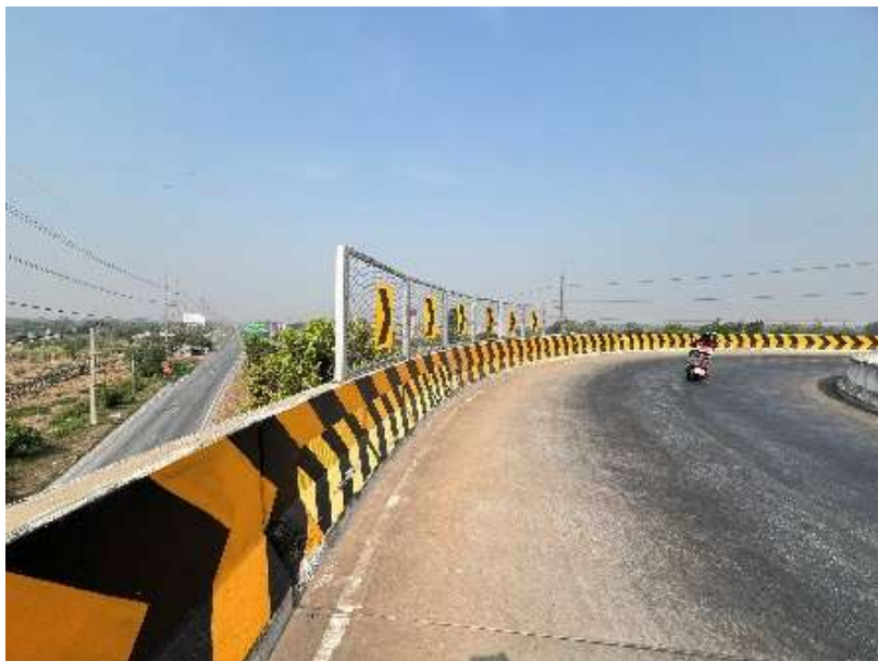
รูปที่ 3-7: สะพานกลับรถเกือกม้า ทล.2 กม.130+250 แนวทางหลวงนครราชสีมาที่ 2 ภายหลังจากปรับปรุง
