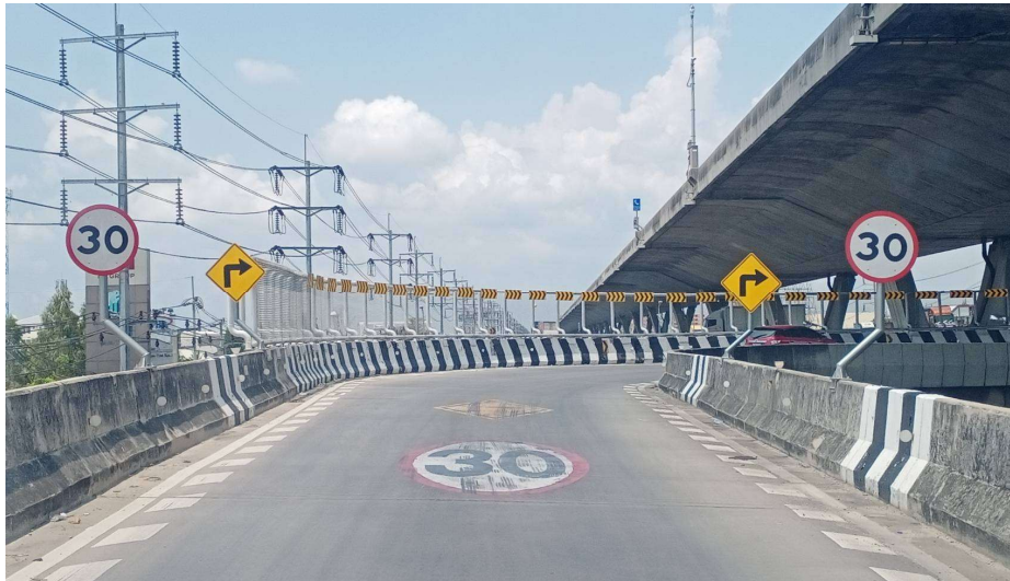
รูปที่ 3-14: สะพานกลับรถเกือบ 15 แห่ง ทล.34 กม.17+220 แนวทางหลวงสมุทราคาร ภายหลังปรับปรุง
