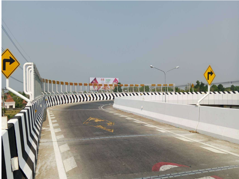
รูปที่ 3-6: สะพานกลับรถเกือกม้า ทล.2 กม.115+540 แนวทางหลวงนครราชสีมาที่ 2 ภายหลังจากปรับปรุง
