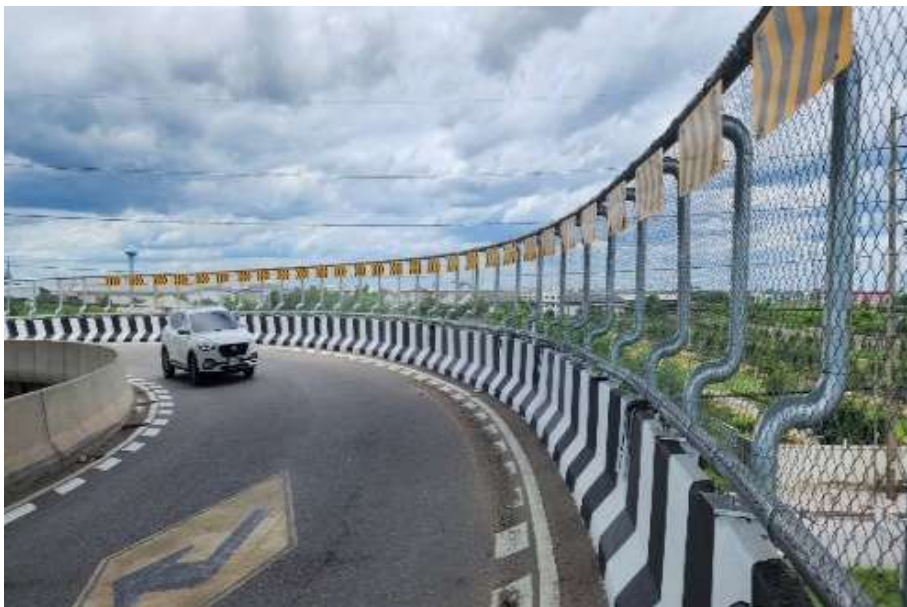
รูปที่ 3-15: สะพานกลับรถเกือบ 10 แห่ง ทล.35 กม.34+400 แนวทางหลวงสมุทรสาคร ภายหลังการปรับปรุง
