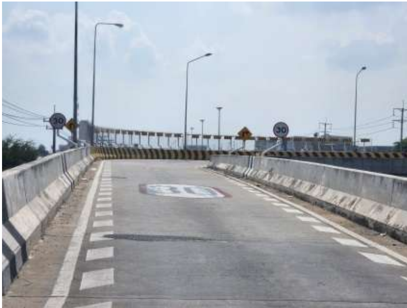
รูปที่ 3-16: สะพานกลับรถเกือบ 14 แห่ง ทล.1 กม.60+950 แนวทางหลวงอยุธยา ภายหลังจากการปรับปรุง
