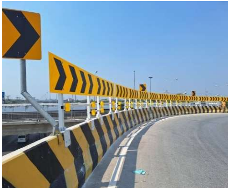
รูปที่ 3-19: สะพานกลับรถเกือบกม. ทล.35 กม.63+000 แนวทางหลวงสมุทรสงคราม ภายหลังจากการปรับปรุง
