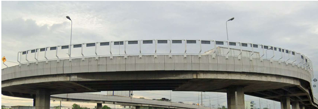
รูปที่ 3-18: สะพานกลับรถเกือบกม. ทล.34 กม.56+425 แนวทางหลวงชลบุรีที่ 1 ภายหลังจากการปรับปรุง
