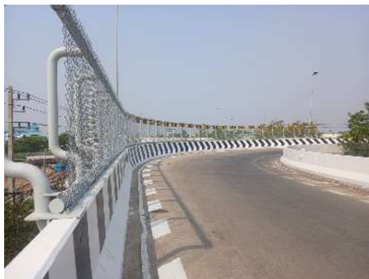
รูปที่ 3-5: สะพานกลับรถเกือบ 2 แห่ง ทล.2 กม.152+386 แนวทางหลวงนครราชสีมาที่ 1 ภายหลังการปรับปรุง
