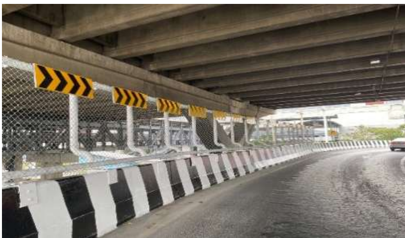
รูปที่ 3-9: สะพานกลับรถเกือบ 8 แห่ง ทล.31 กม.21+170 แขวงทางหลวงกรุงเทพ ภายหลังจากปรับปรุง
