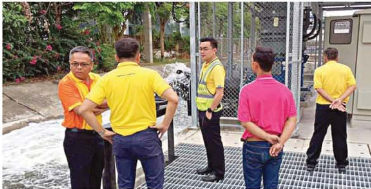
รับมือฝน.... นายธนศักดิ์ วงศ์ธนากิจเจริญ ผู้อำนวยการแขวงทางหลวงกรุงเทพ กรมทางหลวง (ทล.) พร้อมด้วย สุธาร์รัตน์ รองผู้อำนวยการแขวงทางหลวงกรุงเทพ นายวรพงษ์ ขวาชอง หัวหน้าหมวดทางหลวงสุทธิสาร ตรวจสอบระบบระบายน้ำในพื้นที่หมวดทางหลวงสุทธิสาร บริเวณ คูน้ำวิภาวดี ทางหลวงหมายเลข 31 เตรียมพร้อมรับมือฤดูฝนอำนวยความสะดวกประชาชน
