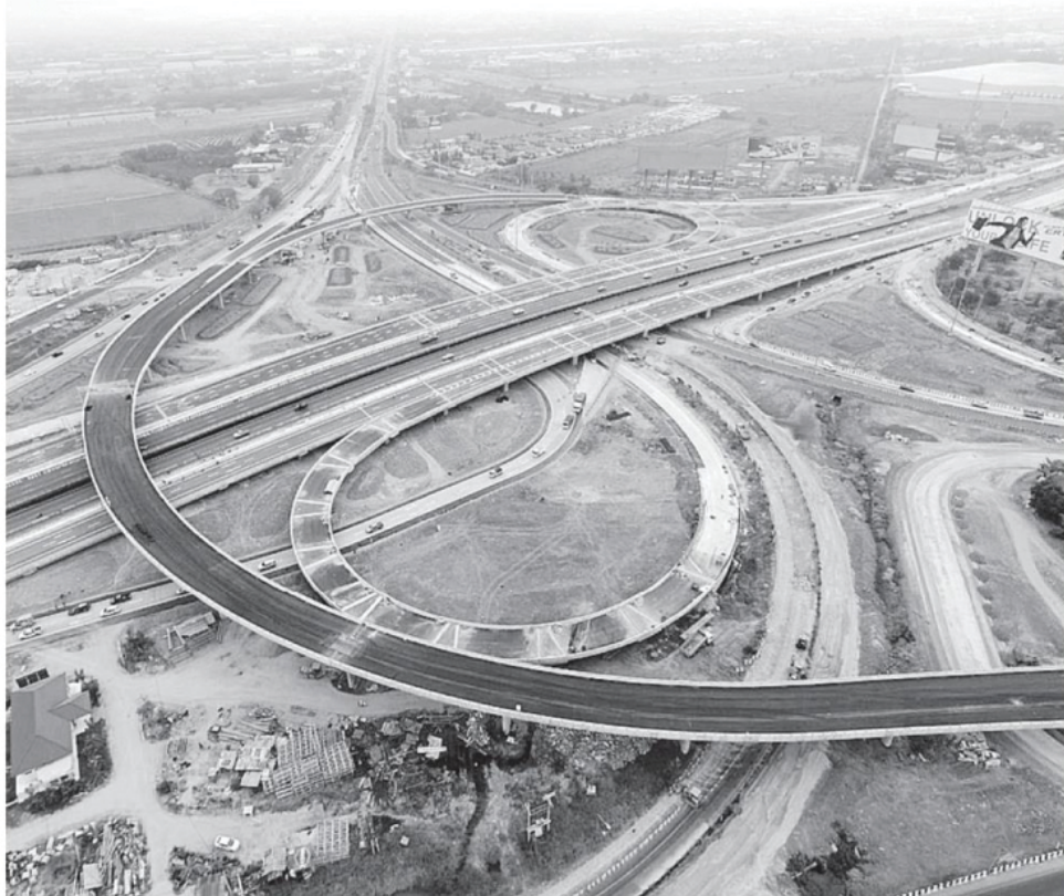
ใกล้เปิดใช้ กรมทางหลวงดำเนินการก่อสร้าง โครงการทางต่างระดับสาย 9 ตัดสาย 345 ปทุมธานี-บางบัวทอง ไปสุพรรณบุรี ชัยนาท ล่าสุดงานก่อสร้างคืบหน้า 92.41% เตรียมเปิดใช้งานเดือน มิ.ย.นี้.
