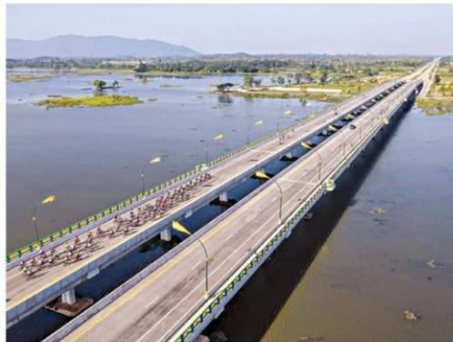
เป็นช่วงสุดท้ายมีจุดเริ่มต้นกม.0+000 ของทล. 1152 บริเวณบ้านห้วยดอย ต.ท่าสาย อ.เมือง จ.เชียงราย และสิ้นสุดกม.19+000 บ้านผางาม ต.ผางาม อ.เวียงชัย จ.เชียงราย รวมระยะทาง 19 กม. เป็นทางหลวงตัดใหม่และตามแนวทล. 1152 เดิมมีขนาด 2 ช่องจราจร (ไป-กลับ) ขยายเป็นแบบมาตรฐานทางชั้นพิเศษ ขนาด 4 ช่อง พร้อมก่อสร้างสะพานข้ามหนองหลวง 2 แห่ง ความยาว 870 เมตร ความกว้าง 11 เมตร และทางเท้ากว้าง 2.75 เมตร ตลอดแนวทั้งสอง
