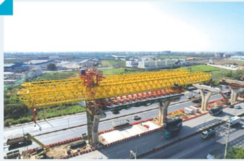
'ทางหลวง-กทพ.' ลุยแก้ปัญหา > 2 โครงการก่อสร้าง 'ถนนพระราม 2'
