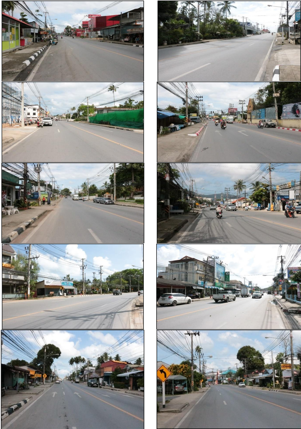
รูปที่ 2-32 (สภาพปัจจุบัน) โครงการก่อสร้างทางหลวงหมายเลข 4169 (สายทางรอบเกาะสมุย)
