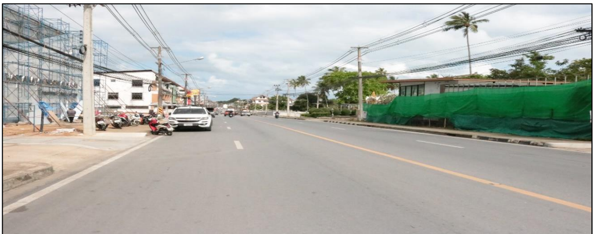
รูปที่ 2-21 สภาพพื้นที่จริงของทางหลวงหมายเลข 4169 ที่ กม. 31+500
