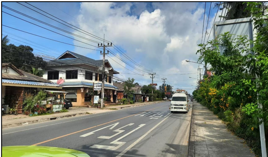
รูปที่ 7-3 การสำรวจค่าความลึกร่องล้อ (Rutting) (สำนักวิเคราะห์และตรวจสอบ)
