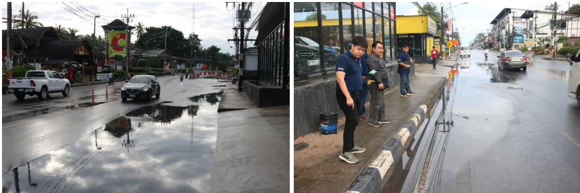
รูปที่ 10-9 ปัญหาท่อระบายน้ำอุดตัน เนื่องจากตะกอนดินทรายจากภูเขาไหลลงสู่ถนน
