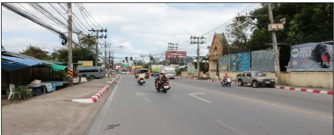
รูปที่ 2-30 สภาพพื้นที่จริงของทางหลวงหมายเลข 4169 ที่ กม. 32+800
