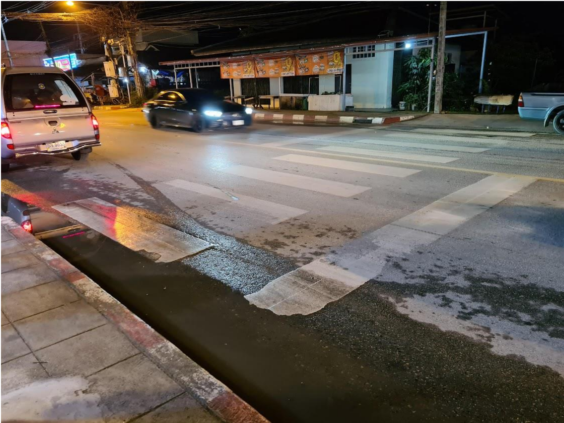
รูปที่ 10-3 การออกแบบทางเท้าบริเวณทางข้าม ที่ไม่เอื้อต่อการใช้งานของกลุ่มเปราะบาง
