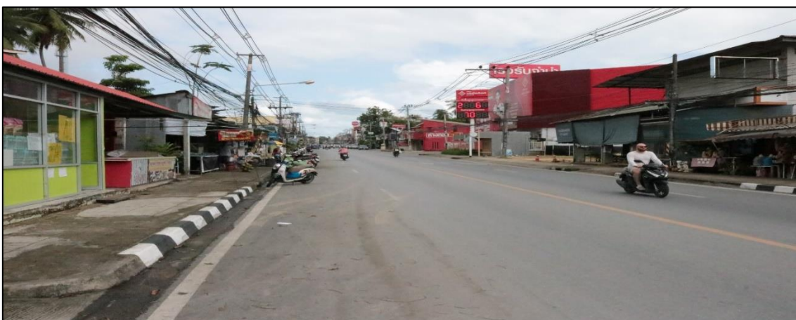
รูปที่ 2-6 สภาพพื้นที่จริงของทางหลวงหมายเลข 4169 ที่ กม. 29+500
