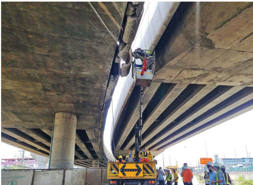
⚠️ เก็บก่อนร่วง - เจ้าหน้าที่แขวงทางหลวงสมุทรสาครเข้าซ่อมแซมแผ่นกันขอบทางสะพานต่างระดับเอกชัย-บางบอน จ.สมุทรสาคร หลังมีผู้โพสต์ภาพแผ่นกันเสียหายกลัวหล่นร่วงลงมาถูกรถด้านล่างชำรุดสะพานพระราม 2 ถล่ม เมื่อวันที่ 3 ส.ค.
