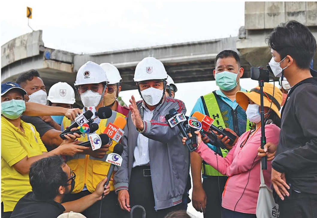
🏠 ตรวจคานถล่ม - ดร.ชนศ วีระศิริ นายกวิศวกรรมสถานแห่งประเทศไทยฯ (วสท.) พร้อมคณะตรวจสอบสะพานกลับรถถนนพระราม 2 จ.สมุทรสาคร ซึ่งเกิดเหตุคานถล่มทับเสียชีวิต 2 ราย ขณะที่กรมทางหลวงเร่งสอบสวนหาสาเหตุเมื่อวันที่ 2 ส.ค.
