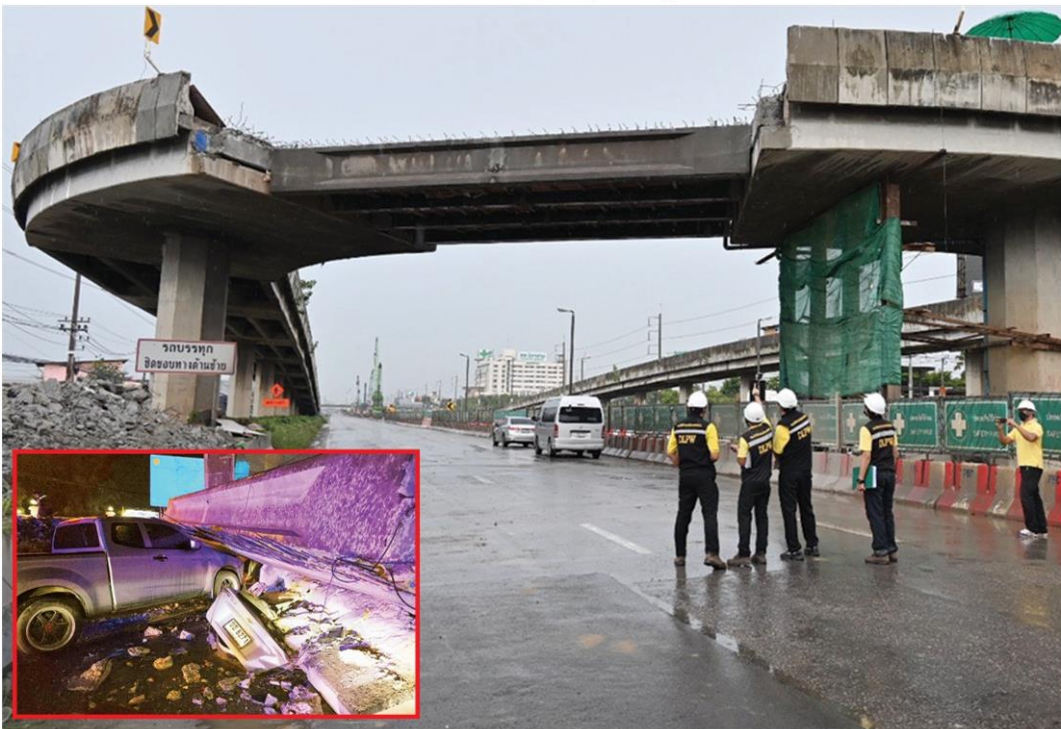
🏠 ถล่มทับรถ - สภาพสะพานกลับรถ ถนนพระราม 2 จ.สมุทรสาคร หลังคานคองกรีตพังถล่มทับรถยนต์ที่วิ่งผ่านพังเสียหายยับ 2 คัน มีผู้เสียชีวิต 2 ราย กรมทางหลวงเร่งสอบสวนสาเหตุ พร้อมขอโทษและชดใช้แก่ผู้เสียหาย เมื่อวันที่ 31 ก.ค.
