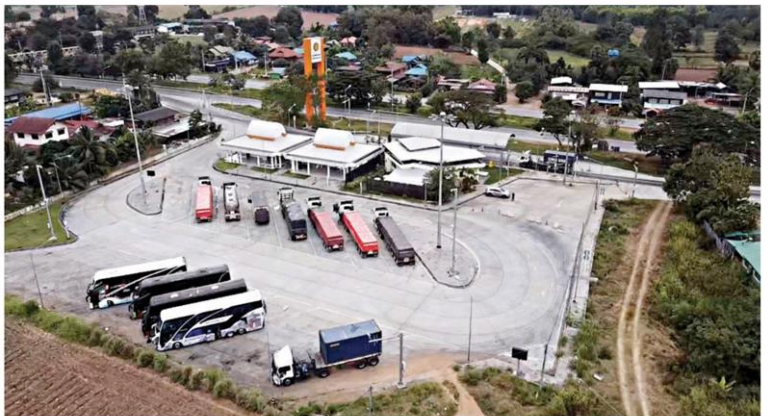
สถานีตรวจสอบน้ำหนักหนองสองห้อง จ.หนองคาย ทล.2 น้ำ
