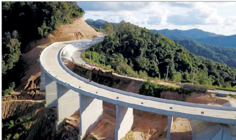
แลนด์มาร์กใหม่ – กรมทางหลวงเปิดใช้สะพานกิโลม บนทางหลวงหมายเลข 1263 ตอน ขุนยวม-ปางอุ๋ง ความยาว 160 เมตร เพื่อให้ผู้ใช้ทางได้รับความสะดวกปลอดภัย และ เป็นจุดส่งเสริมการท่องเที่ยวใน จ.แม่ฮ่องสอน
