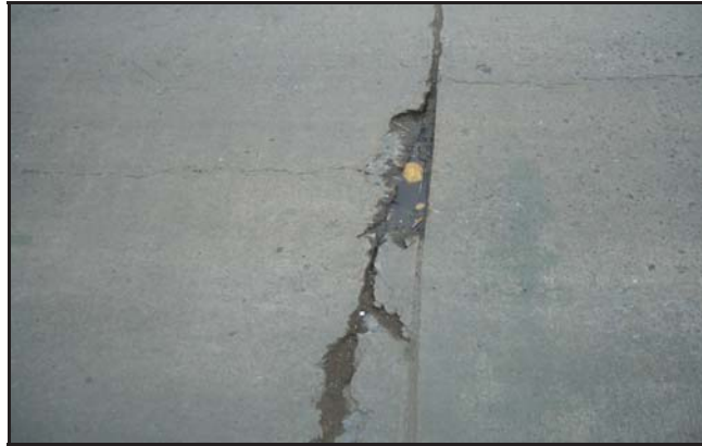
รูปรอยบิ่นกะเทาะที่รอยต่อตามขวาง รอยต่อตามยาว หรือรอยแตก
