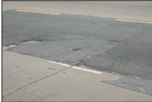
รูปรอยปะซ่อมผิวคอนกรีต
