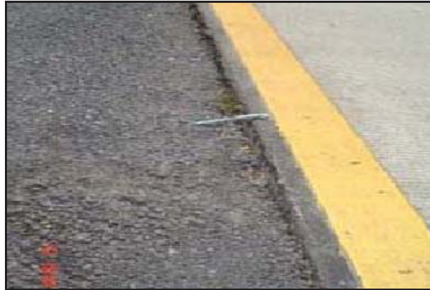
รูปการทรุดตัวต่างระดับของไหล่ทาง
