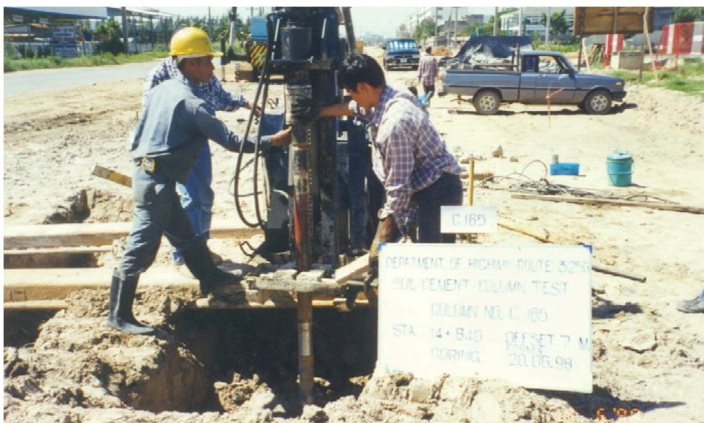
ภาพแสดงการ Coring Cement Column เก็บตัวอย่างไปทดสอบในห้องทดลอง
