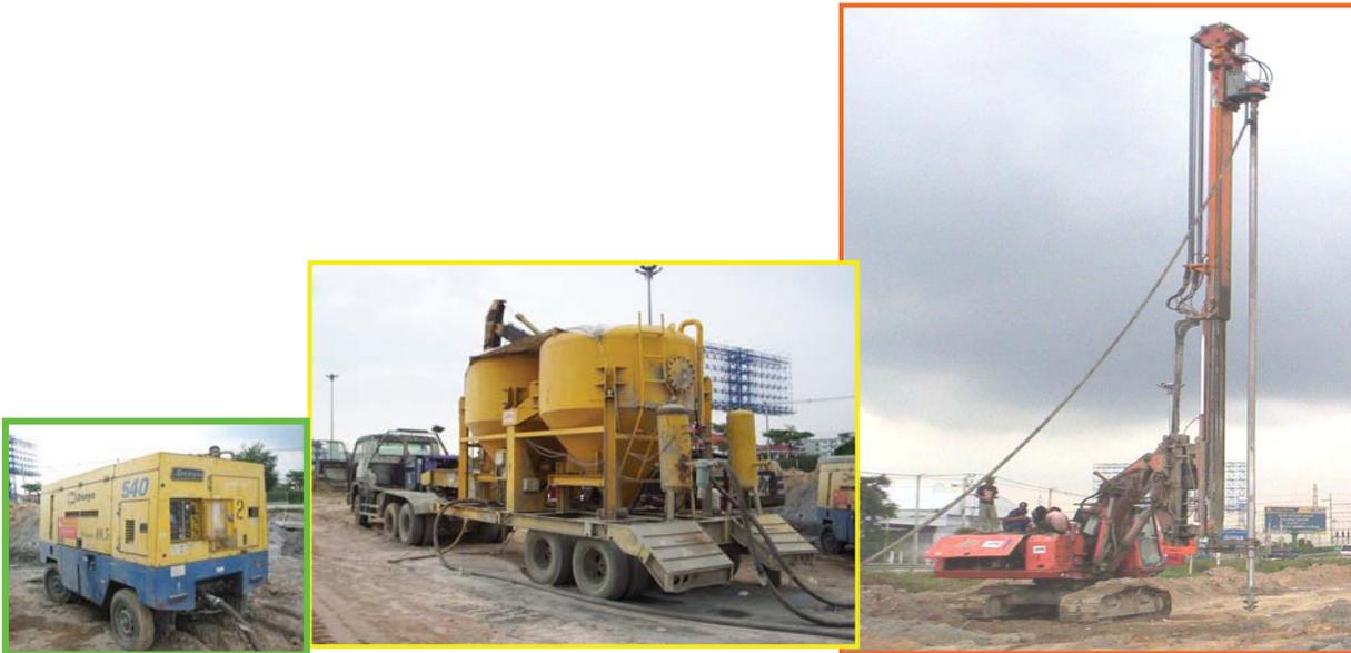
ภาพแสดงลักษณะของเครื่องจักรในระบบ Dry Mixing
