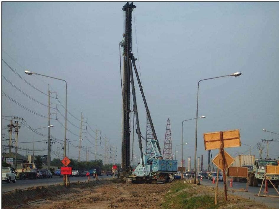
ภาพแสดงลักษณะของเครื่องจักรระบบ Wet Mixing
