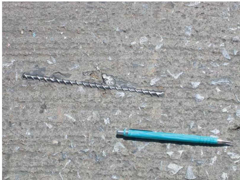
รูปที่ 6-1 การชำรุดของพื้นสะพานคอนกรีต แสดงให้เห็นว่า เหล็กเสริมหลักมีทิศทางตั้งฉากกับทิศทางการจราจร
