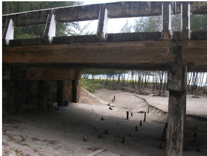
รูปที่ 2-28 Concrete Abutment
