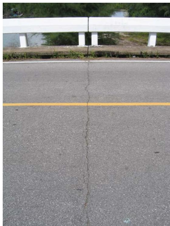
รูปที่ 6-8 Transverse Crack ที่เกิดขึ้นที่ด้านบนของ Expansion Joint
