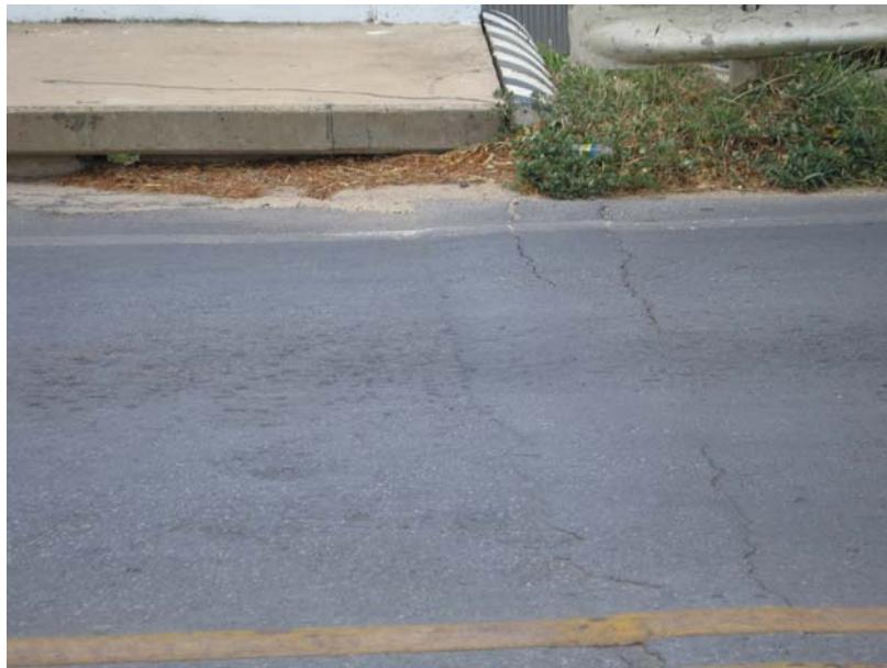
รูปที่ 6-9 Heaving of the Approach Pavement
