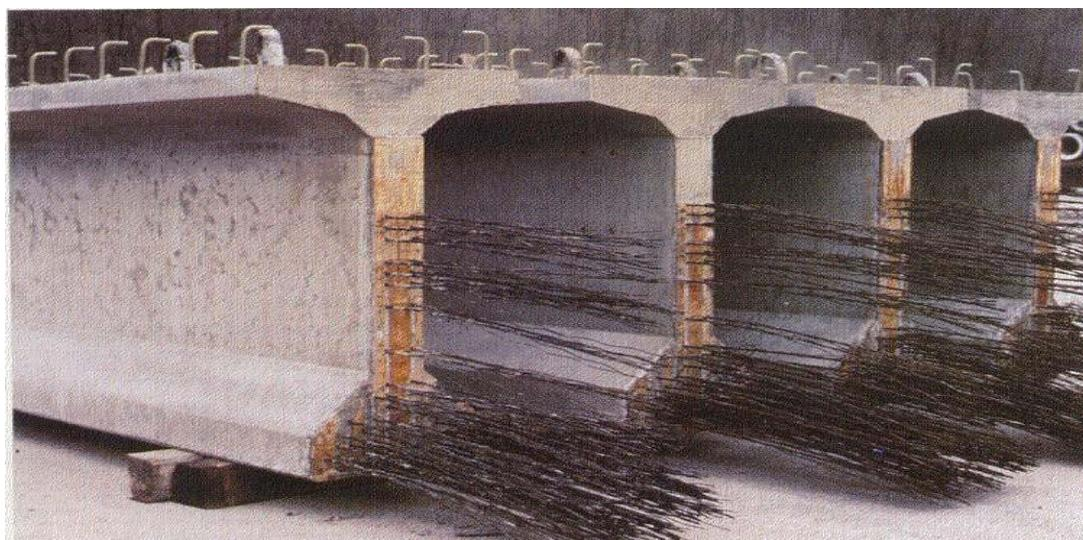
รูปที่ 3-4 ขั้นตอนการอัดแรงชนิดดึงก่อน (Pretensioning)
