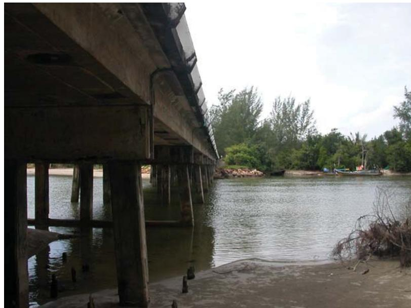
รูปที่ 2-33 การถูกกัดเซาะของท้องน้ำ
