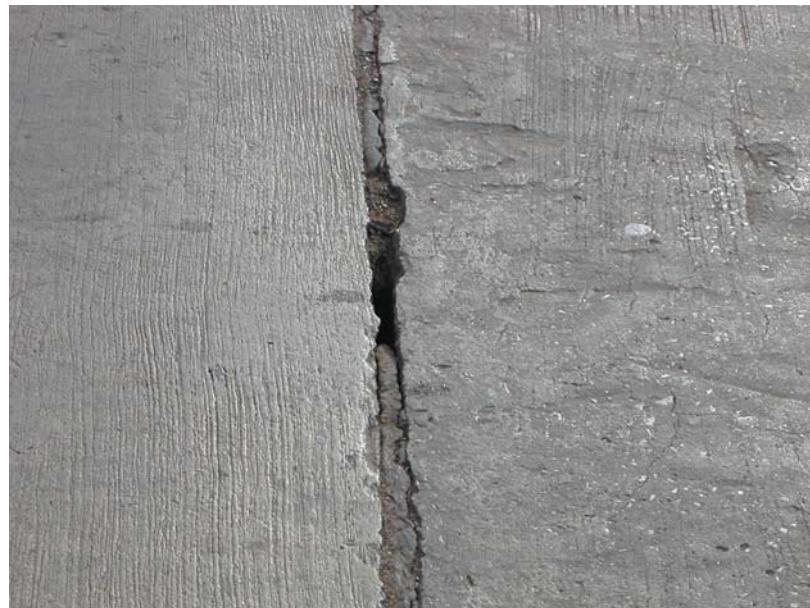
รูปที่ 6-7 ความเสียหายของ Compression Seal
