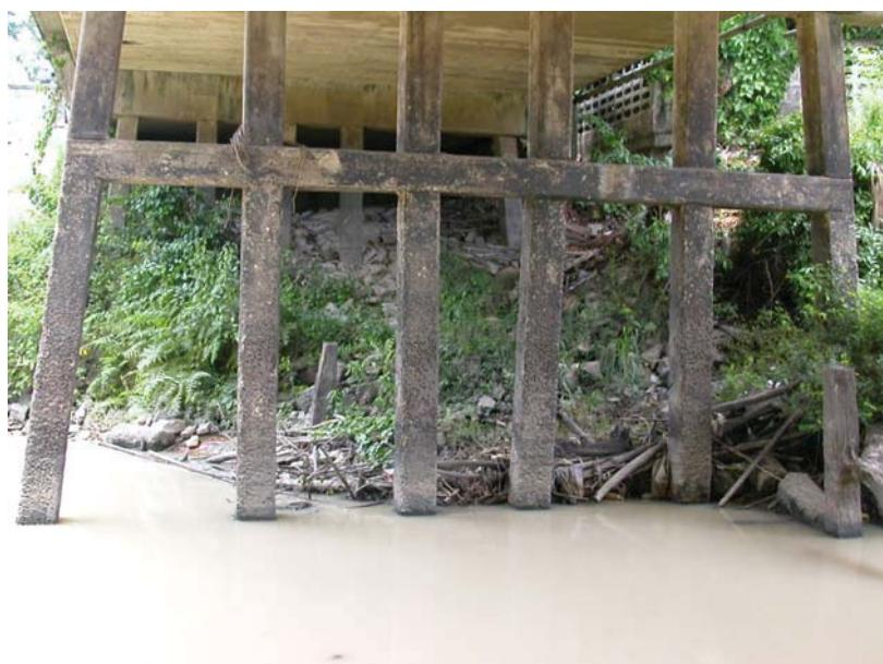
รูปที่ 6-32 การกัดกร่อนและการทับถมของเศษอิฐที่ตอนม่อคลางน้ำเหล็ก
