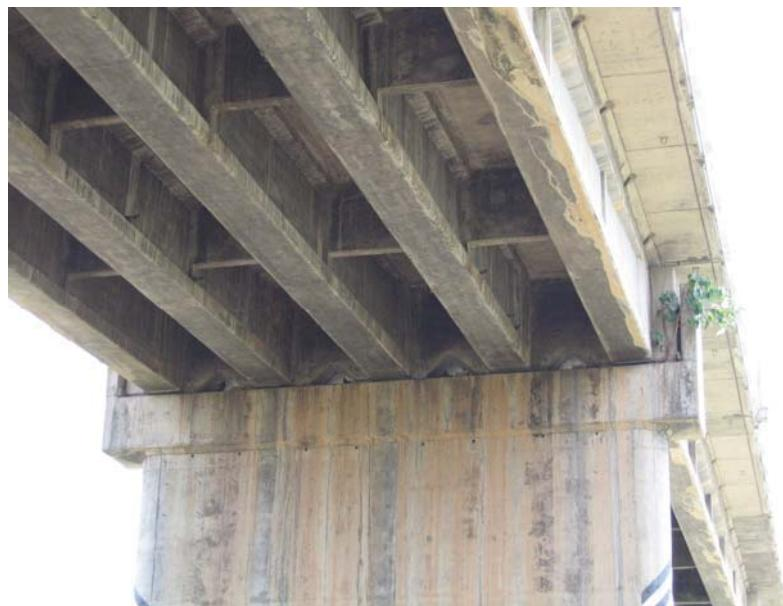
รูปที่ 6-18 สะพานแบบ Prestressed I-Beam
