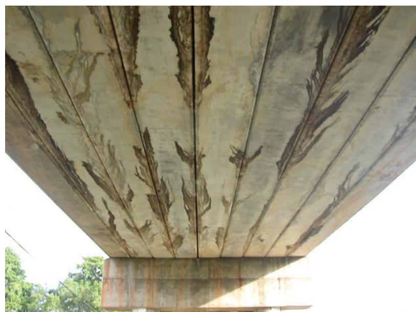
รูปที่ 6-17 Leaking Joints ที่ระหว่าง Boxes ซึ่งอยู่ติดกัน
