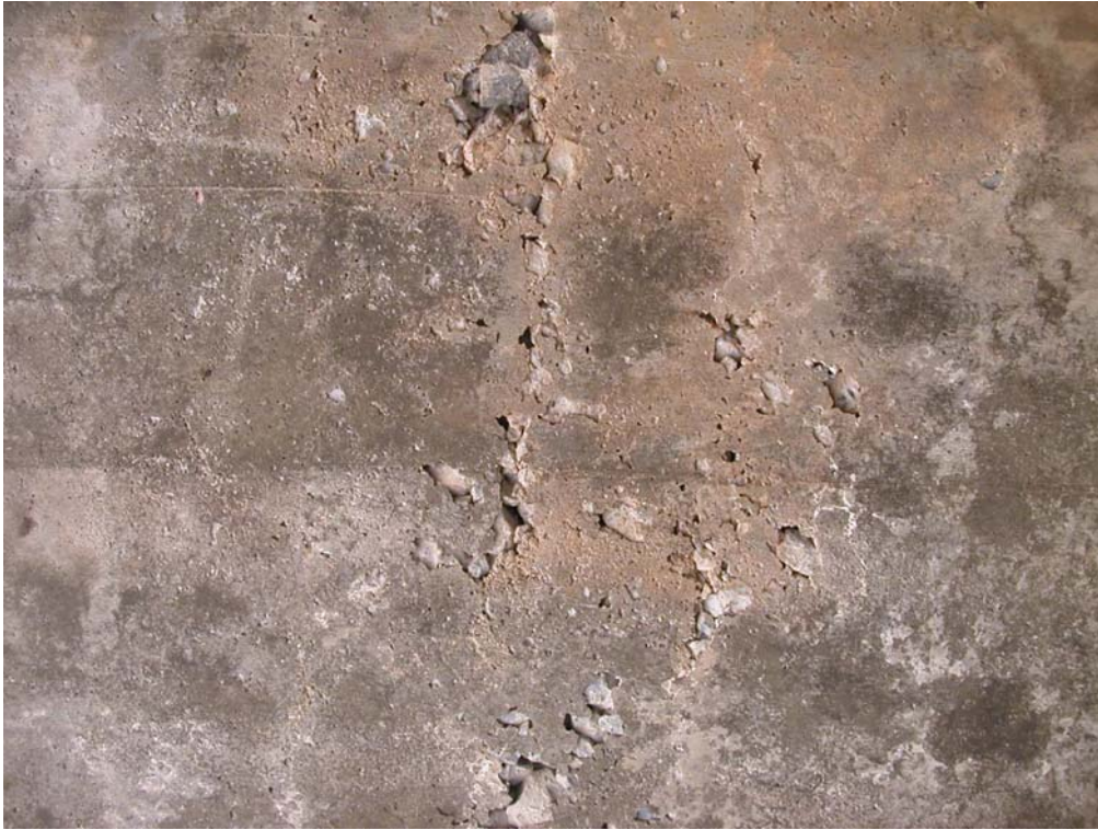
รูปที่ 3-3 คอนกรีตอิ่มตัวด้วยน้ำ (Water Saturated Concrete)
