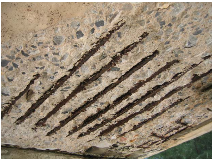
รูปที่ 2-10 การเกิดสนิมในเหล็กเสริม
