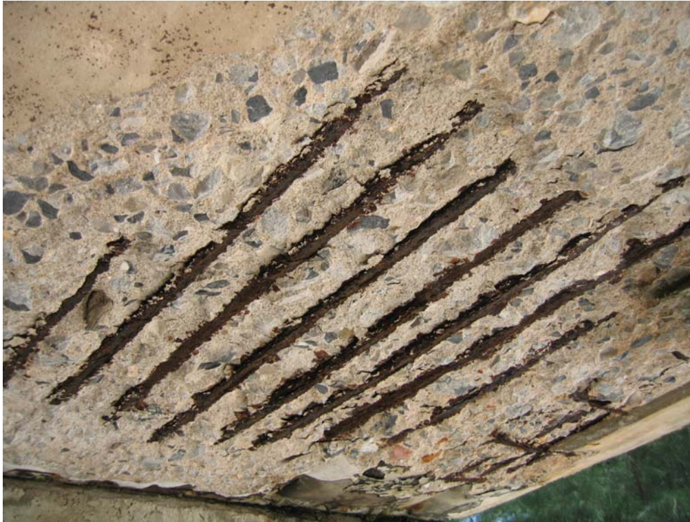
รูปที่ 3-1 การเสียหายอย่างรุนแรงที่ด้านล่างของพื้นสะพาน
