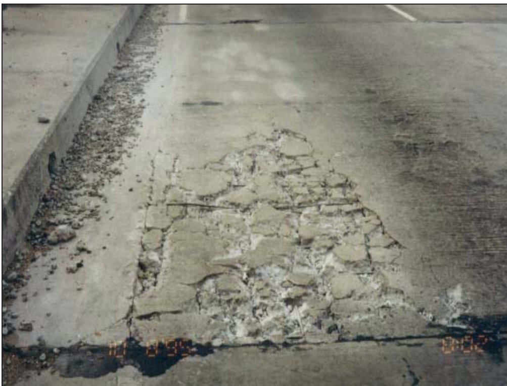
รูปที่ 3-2 การเสียหายอย่างรุนแรงที่ด้านบนของพื้นสะพาน
