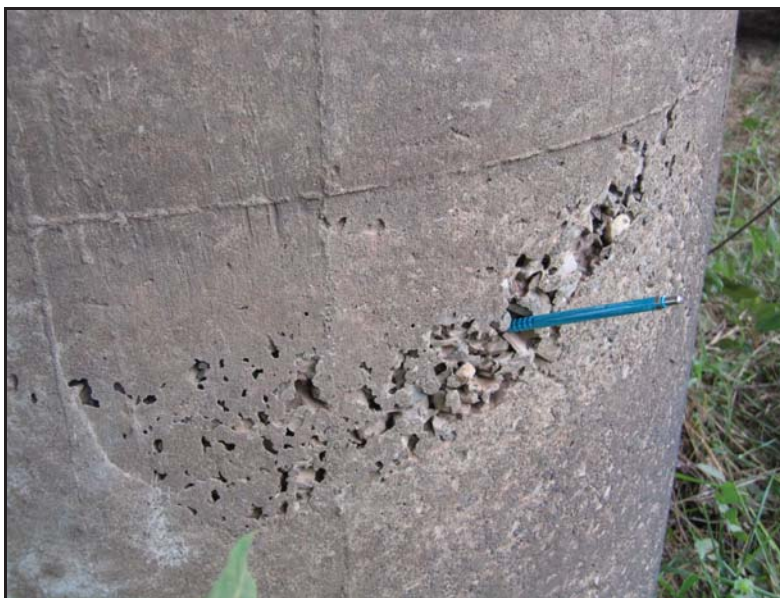
รูปที่ 2-7 การเกิดรูพรุนเหมือนรวงผึ้ง
