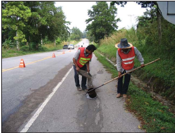
รูปที่ 2.1.2 อุดรอยแตกด้วยแอสฟัลต์เหลว
