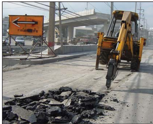
เครื่องจักรขุดไส (Milling Machine) สำหรับขุดไสถนนบางส่วนที่เสียหายออก
