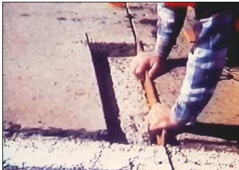
รูปที่ 3.5.4 ติดตั้งแบบเพื่อเป็นฉากกั้นแนวรอยต่อผิวคอนกรีต
