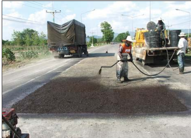
รูปที่ 2.7.3 กรณีปูด้วย Cold Mix อัจราดแอสฟัลต์เพื่ออุดช่องว่าง
