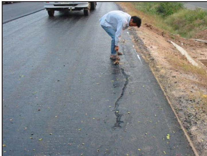
รูปที่ 2.1.1 เตรียมพื้นที่ ที่จะทำการอุดซ่อม
