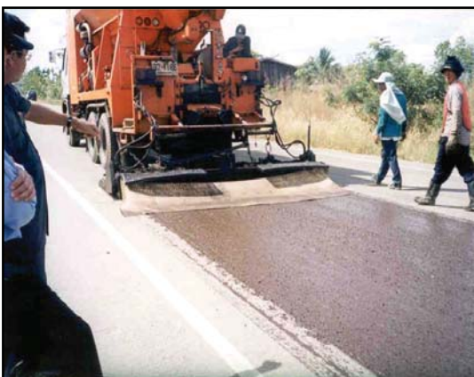
รูปที่ 2.4.3 การฉาบผิวทางแบบ Slurry Seal
