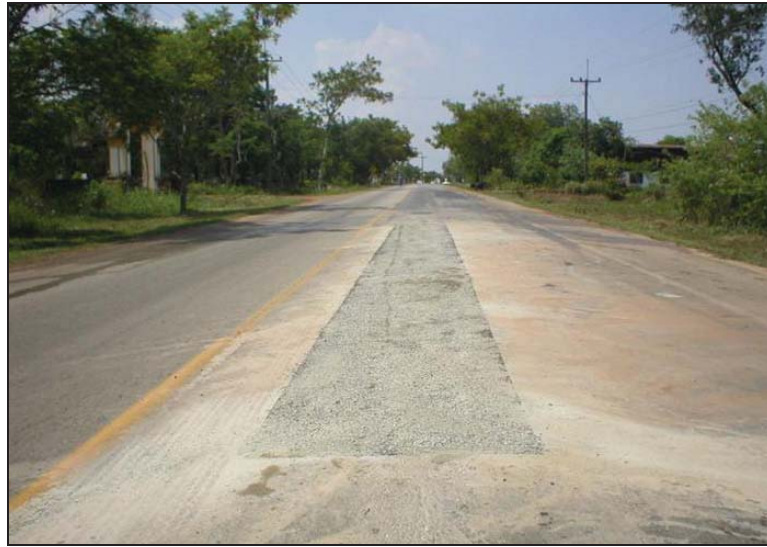
รูปที่ 2.5.7 กรณีปูทับด้วย Cold Mix ต้องสาดหินฝุ่นปิดทับตลอด
