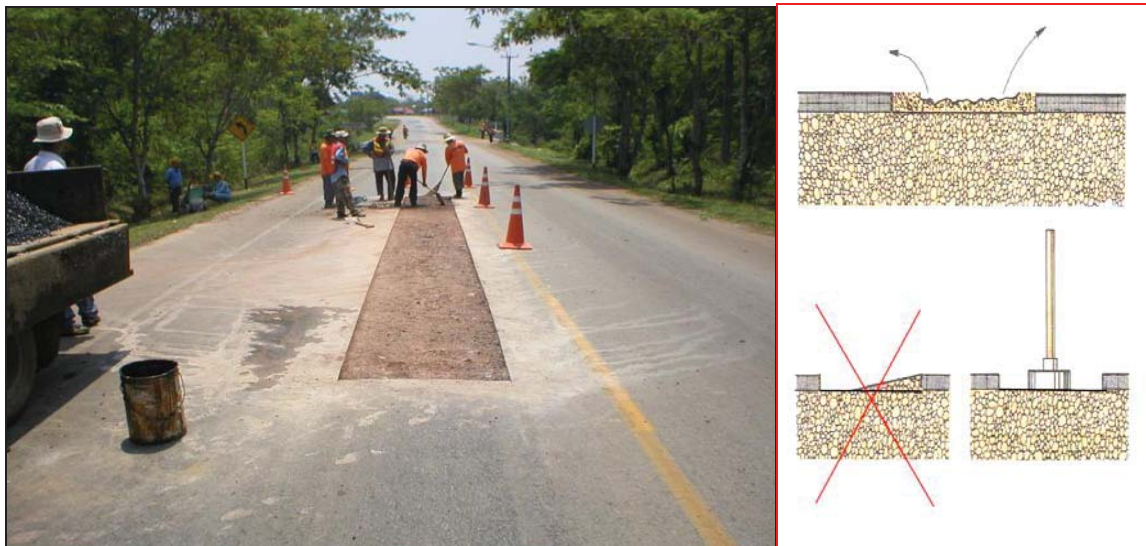
รูปที่ 2.5.2 รอยตัดต้องเรียบและตั้งฉาก
