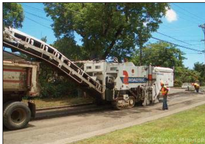
เครื่องจักรขุดไส (Milling Machine) สำหรับขุดไสถนนบางส่วนที่เสียหายออก
