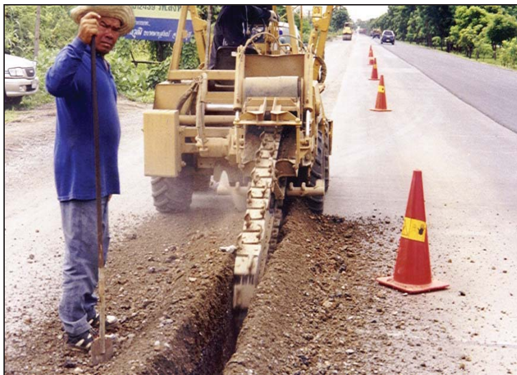
รูปที่ 4 ชูตร่องตามแนวที่กำหนด
