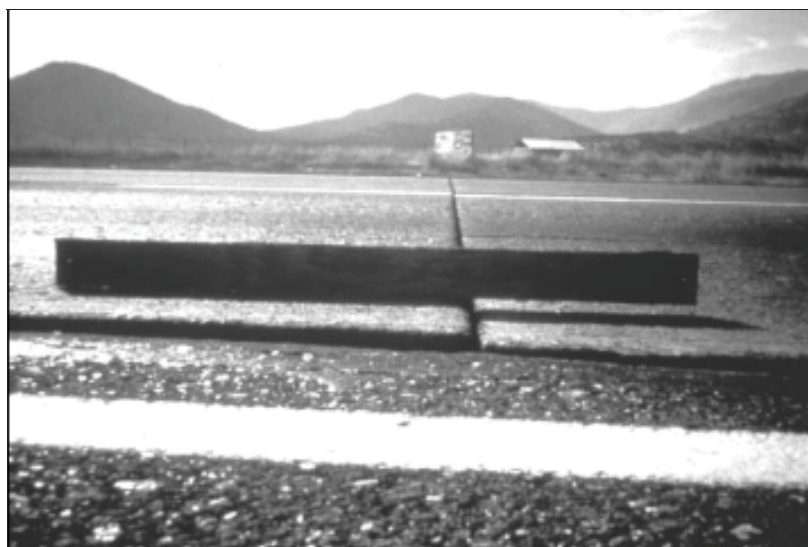
รูปที่ 3.3.1 การชุดแต่งผิวหน้าคอนกรีตสามารถใช้ปรับปรุงผิวหน้าบริเวณรอยต่อที่ไม่เรียบ
