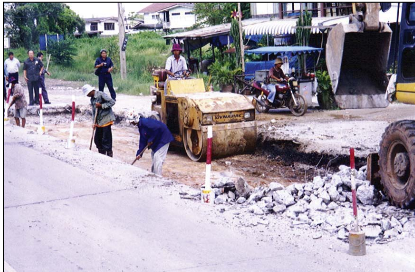
รูปที่ 3.7.4 บดอัดพื้นที่ก่อนที่จะทำการซ่อมแซม
