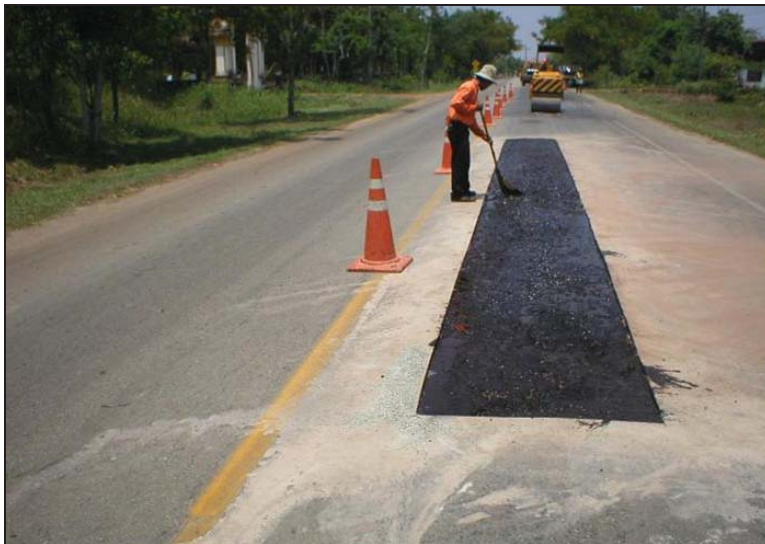
รูปที่ 2.5.4 Tack Coat พื้นที่ ที่จะปะซ่อม
