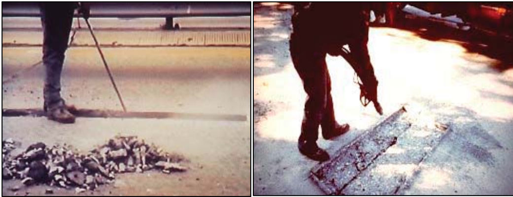
รูปที่ 3.5.3 ทำความสะอาดด้วยเครื่องพ่นทราย (Sand Blast) และเครื่องเป่าลม
