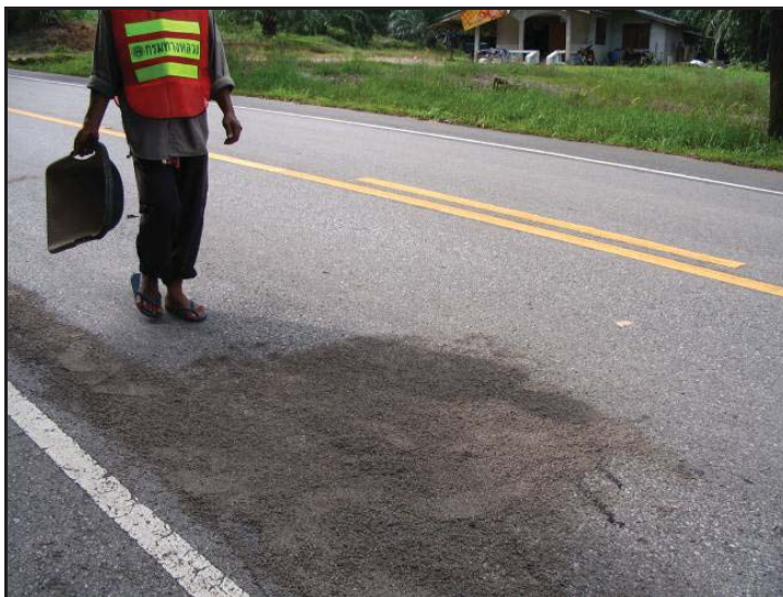
รูปที่ 2.1.3.สาดทรายปิดทับรอยแตกที่อุดด้วยด้วยแอสฟัลต์แล้ว
