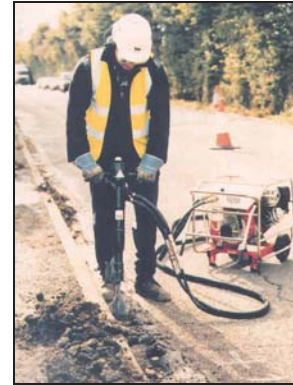
เครื่องเจาะขุดผิวทางและชั้นทาง
