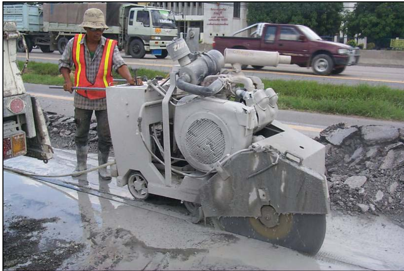
รูปที่ 3.7.2 แยกพื้นที่ที่จะทำการซ่อมแซมด้วยวิธีการใช้เลื่อยตัดคอนกรีต
