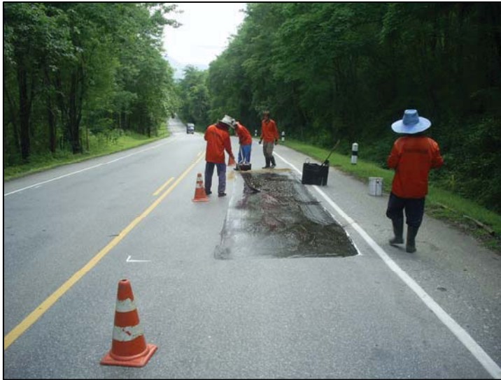
รูปที่ 2.3.2 ลาดแอสฟัลต์ที่เตรียมไว้
