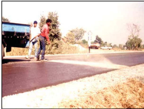
รูปที่ 2.4.6 การสาดทรายบริเวณทางเชื่อม
