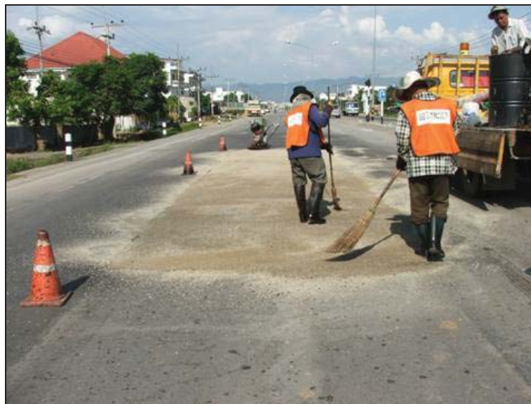
รูปที่ 2.7.4 สาดหินฝุ่นปิดทับก่อนเปิดการจราจร
