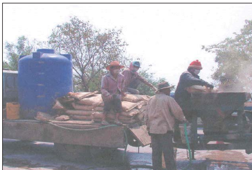
รูปที่ 3.6.6 ผสมวัสดุอุดซ่อมตามสัดส่วนที่กำหนด
