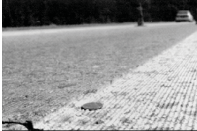
รูปที่ 3.3.4 ลักษณะของผิวหลังจากทำ Grinding แล้ว
