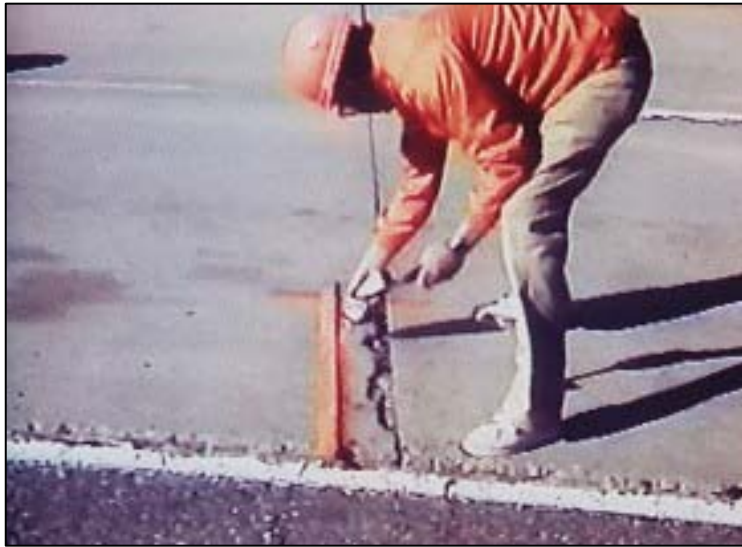
รูปที่ 3.5.2 กำหนดขอบเขตของความเสียหาย
