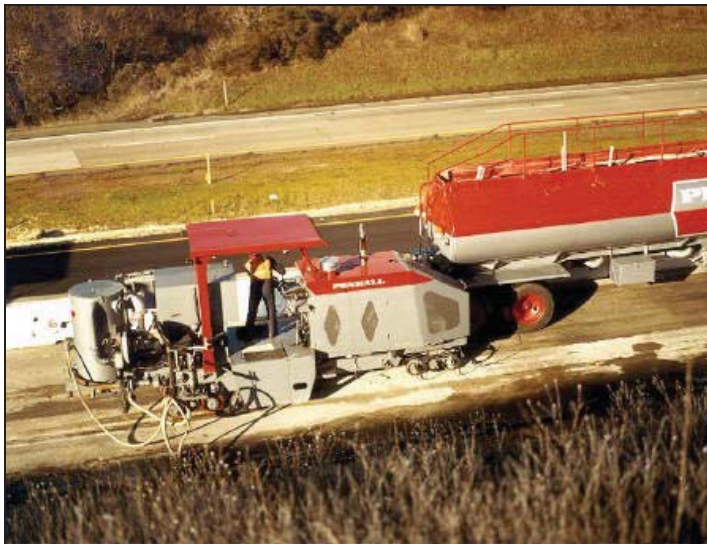
รูปที่ 3.3.2 เครื่องจักร Grinding and grooving และเครื่องดูดกากคอนกรีต
