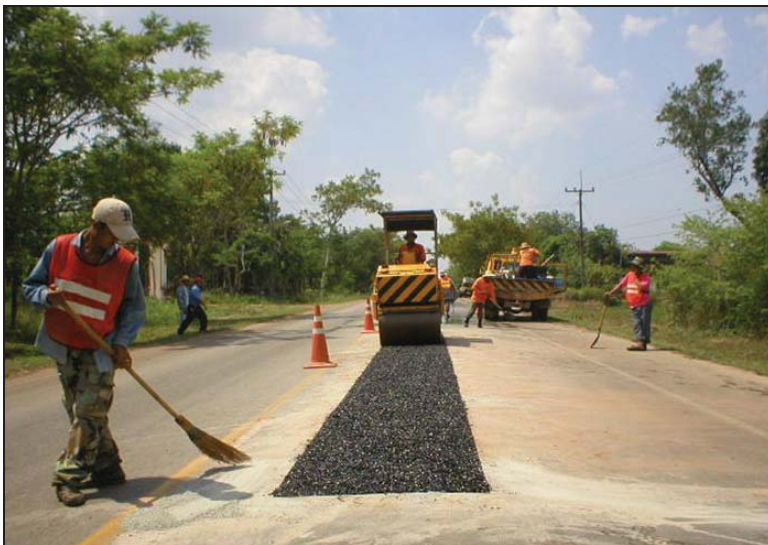
รูปที่ 2.5.6 บดทับด้วยรถบดล้อเหล็ก
