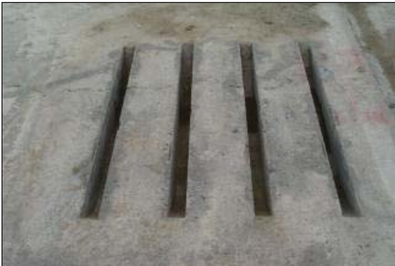
รูปที่ 3.4.3 เจาะร่องคอนกรีตตามตำแหน่งที่กำหนดพร้อมทำความสะอาด
