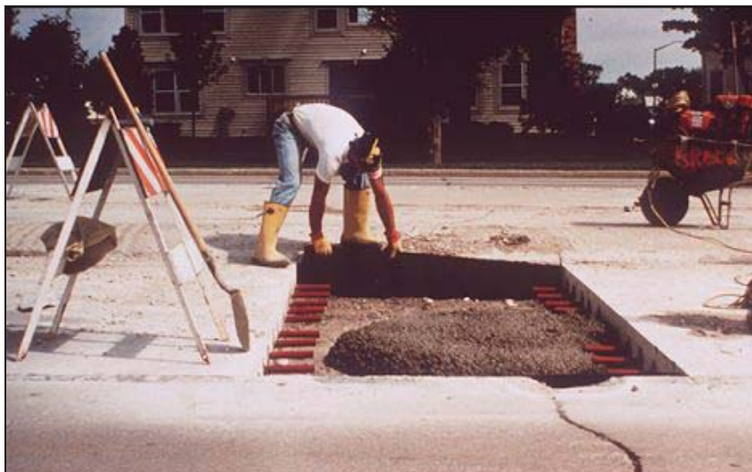
รูปที่ 3.7.6 เทคอนกรีตลงในพื้นที่ที่เตรียมไว้
