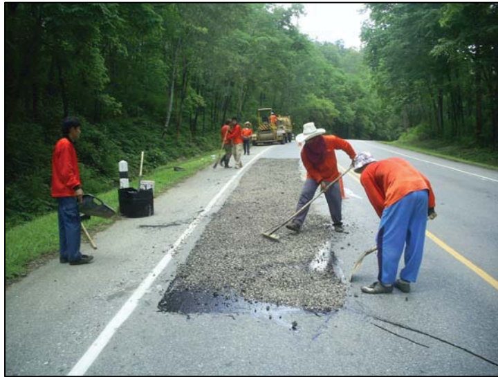
รูปที่ 2.3.3 โรยหินย่อยหรือกรวดย่อยปิดทับหน้าแอสฟัลต์
