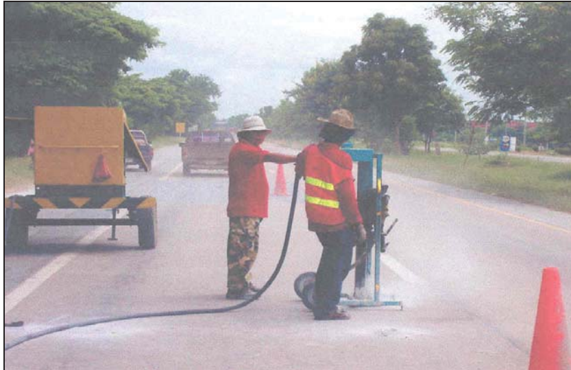
รูปที่ 3.6.5 เจาะรูแผ่นพื้นคอนกรีต
