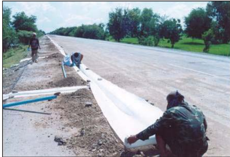
รูปที่ 5 ปูแผ่น Geotextile และวางท่อ PVC
