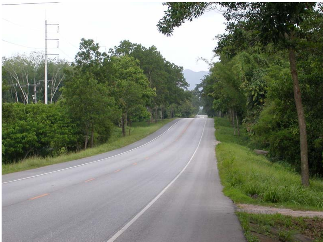
รูปที่ 1.3 อันตรายจากระยะมองเห็นปลอดภัยไม่พอเพียง
