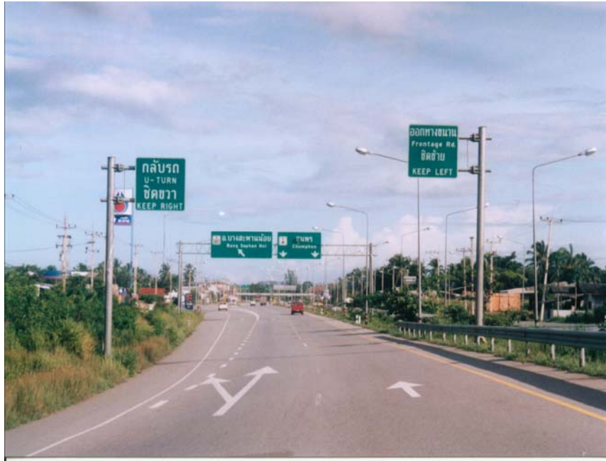
รูปที่ 1.4 การติดตั้งป้ายที่มีระยะใกล้เกินไป จะทำให้ผู้ขับขี่ประมวลข้อมูลไม่ทัน
