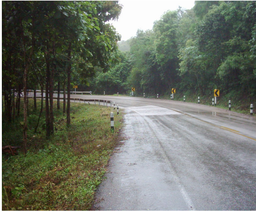
รูปที่ 1.14 การขุดระยะมองเห็นที่ปลอดภัยบริเวณโค้ง
