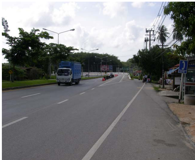
รูปที่ 1.17 การมีจุดเชื่อมทางบริเวณปลายทางโค้ง
