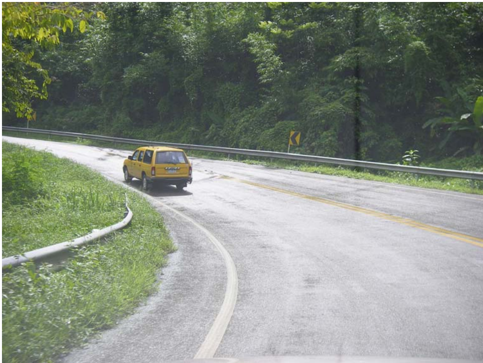
รูปที่ 1.11 ลักษณะโค้งอันตรายขณะที่พื้นถนนเปียก
