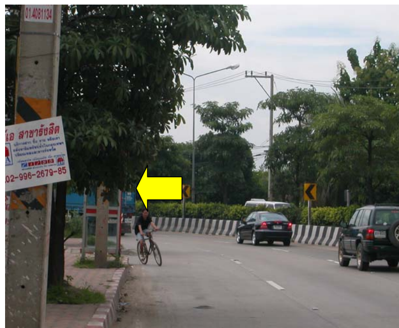
รูปที่ 1.8 ตู้โทรศัพท์ที่อยู่ใกล้แยกบริเวณโค้ง ทำให้ผู้ขับขี่มองไม่เห็นแยก
