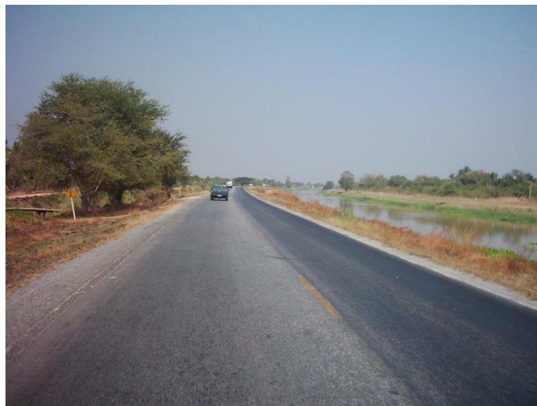
รูปที่ 3.14 ด้านสภาพอันตรายข้างทาง
