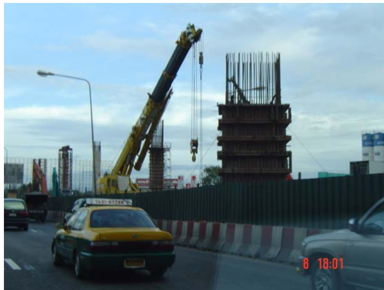
รูปที่ 3.8 ด้านการติดตั้งอุปกรณ์กันชน
