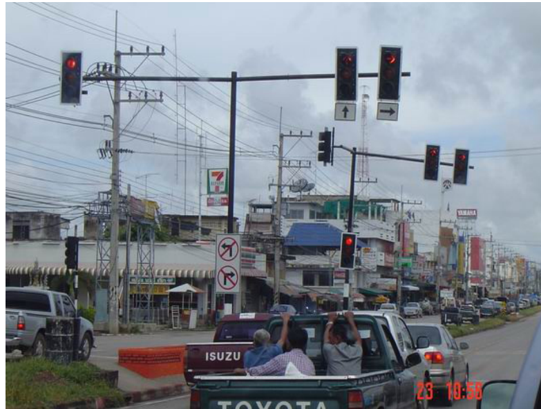
รูปที่ 3.11 ด้านการติดตั้งไฟจราจร
