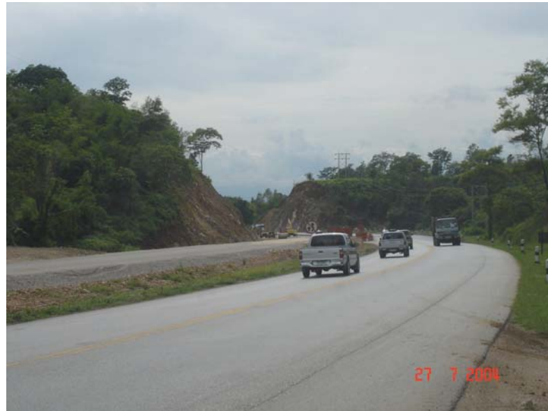
รูปที่ 3.1 ด้านการติดตั้งไฟจราจรชั่วคราว
