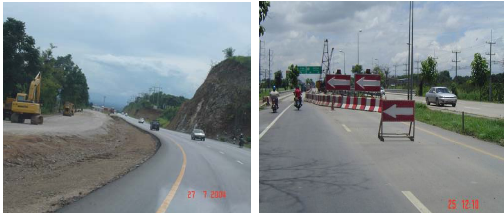
รูปที่ 2.1 ความปลอดภัยในขั้นตอนการก่อสร้างถนน
