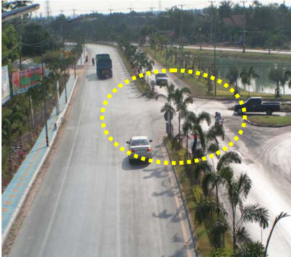
รูปที่ 1.4 ระยะมองเห็นไม่พอเพียงช่วงทางแยก
