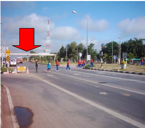
รูปที่ 1.5 การติดตั้งสะพานลอยที่ไม่ตรงกับจุดที่เหมาะสมกับการใช้งาน
