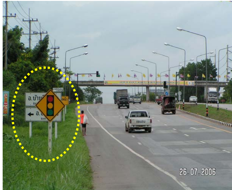
รูปที่ 1.7 การติดตั้งป้ายที่ใกล้กันเกินไป
