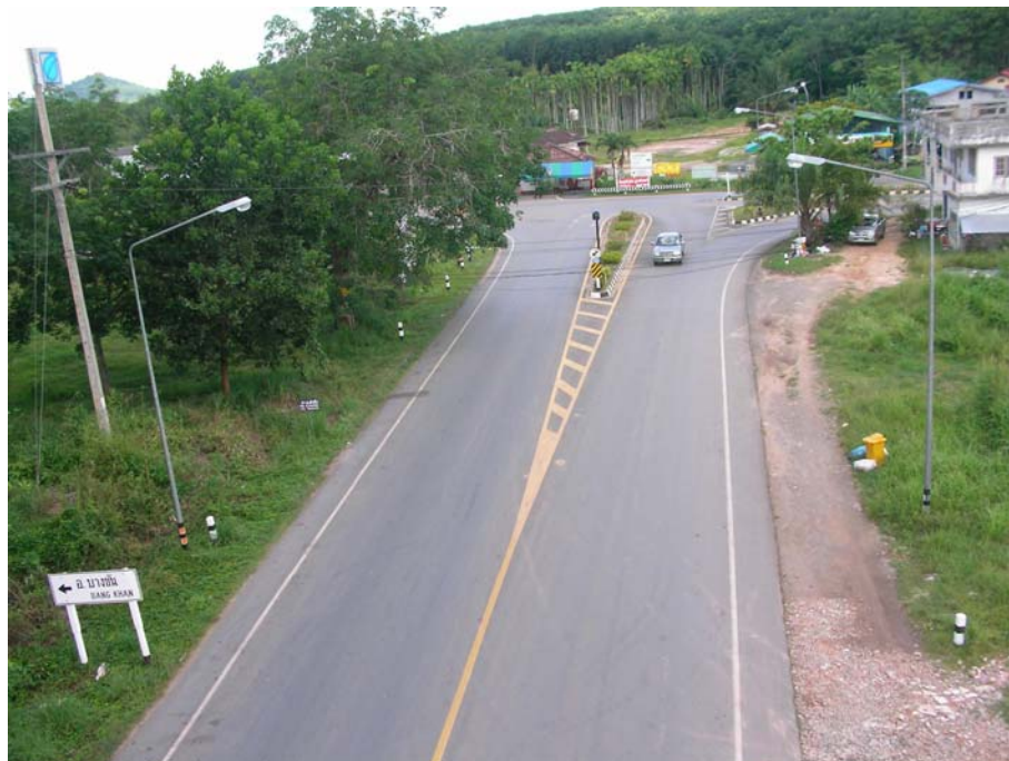
รูปที่ 4.3 การทำสีเพื่อความชัดเจนในการแบ่งทิศทางการจราจรบนโค้งแนวตั้งบริเวณทางแยก
