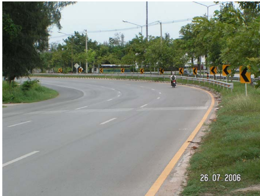
รูปที่ 4.8 การติดตั้งราวกันอันตราย
