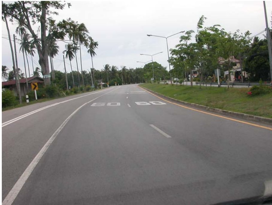
รูปที่ 4.10 การบอกความเร็วก่อนเข้าโค้งบนผิวทาง
