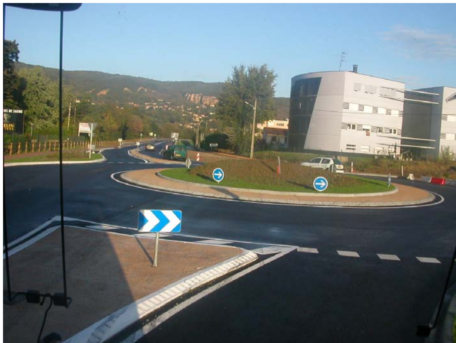
รูปที่ 4.5 การควบคุมการจราจรโดยใช้วงเวียน
