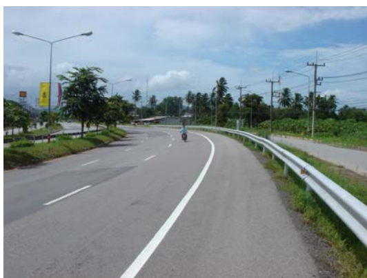
รูปที่ 4.7 การติดตั้งราวกันอันตราย
