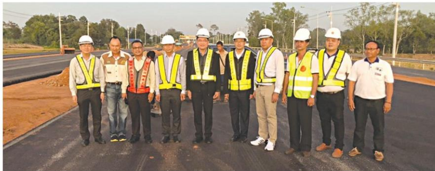
ตรวจงาน... นายกิตติพันธ์ ปานจันทร์ รองอธิบดีกรมทางหลวง (ทล.) ประธานกรรมการตรวจรับพัสดุ พร้อมด้วย นายพัลลภ จันทร์งามปภากุล ผู้อำนวยการสำนักงานทางหลวงที่ 3 กรมการฯ ลงพื้นที่ตรวจสอบชั้นพื้นที่ทางโครงการก่อสร้างทางหลวงหมายเลข 12 สายบ้านนาโคก-อ.คำชะอี ตอน อ.หนองสูง-อ.คำชะอี (แนวใหม่) ระหว่าง กม.721+000-740+708 ระยะทาง 19.708 กม. วงเงิน 1,196,376,000 บาท
