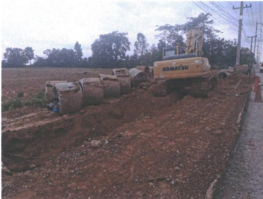
รูปที่ ๒ ดำเนินการรื้อท่อกลม ค.ส.ล. ที่มีสภาพหน้างานไม่ตรงตามรูปแบบและระดับก่อสร้าง
